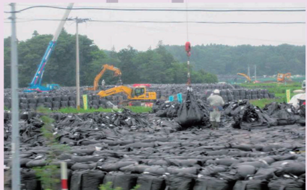
大熊町の除染土壌仮置き場
