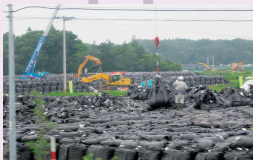
大熊町の除染土壌仮置き場
